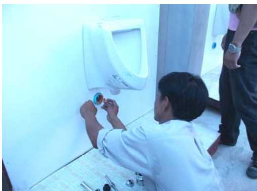
ภาพที่ 3-41 ฝึกปฏิบัติการติดตั้งสุขภัณฑ์
