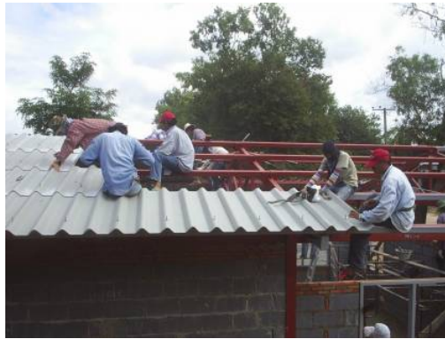
รูปที่ 7 ตัวอย่างงานมุงหลังคาลอนคู่
