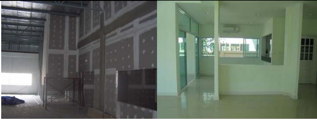
รูปที่ 1 ตัวอย่างงานผนังยิปซัม
