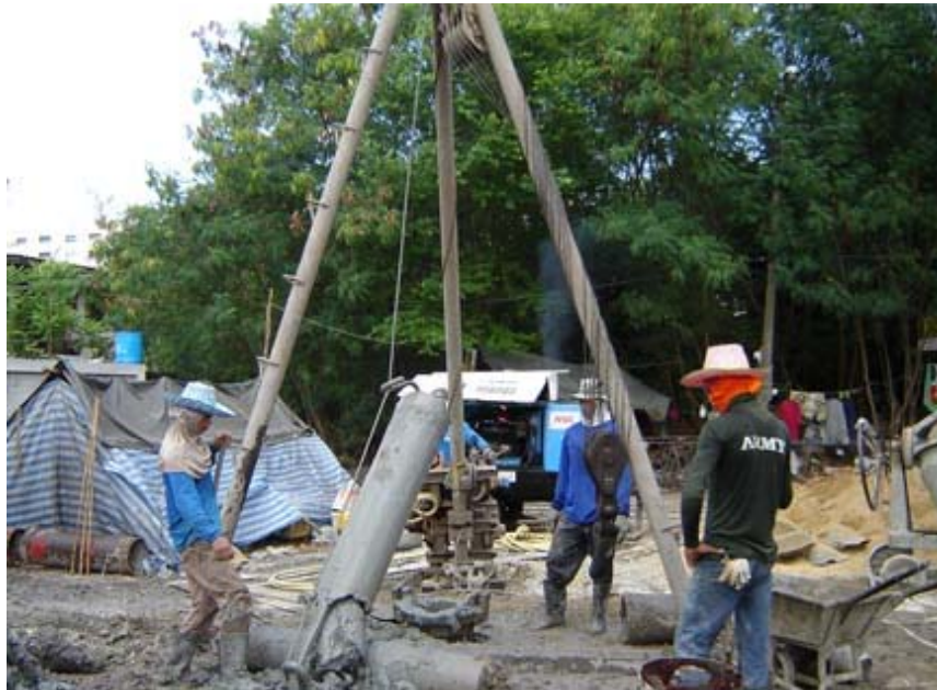
รูปที่ 1 การทำเสาเข็มเจาะ (ที่มา :www.selectcon.com)
